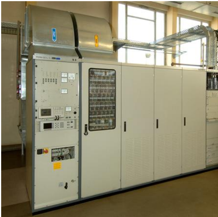
DCF77 - koncový stupeň vysílače ( www.ptb.de )
