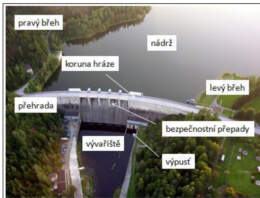
Obrázek 85 Části přehradní nádrže na příkladu Kružberku (vlastní zpracování, foto: kruzberk.cz)
