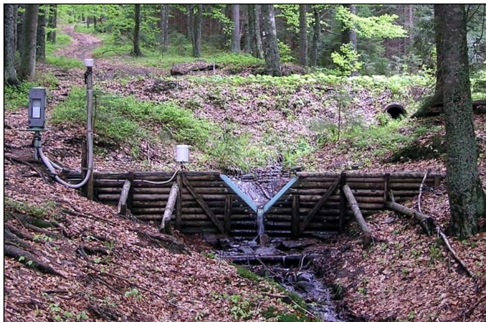
Obrázek 34 Thomsonův přepad k měření průtoků na drobném vodním toku (zdroj: www.kvhem.cz)
