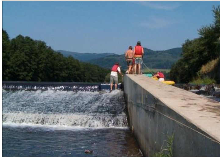
Obrázek 81 Jez na řece Ohři, nedaleko Karlových Varů – vodáci překonávají jez propustí vpravo. Dynamický účinek vodního skoku vytvořeného jezem je tlumen šikmou přelivnou plochou. (foto: J. Frajer, 2005)
