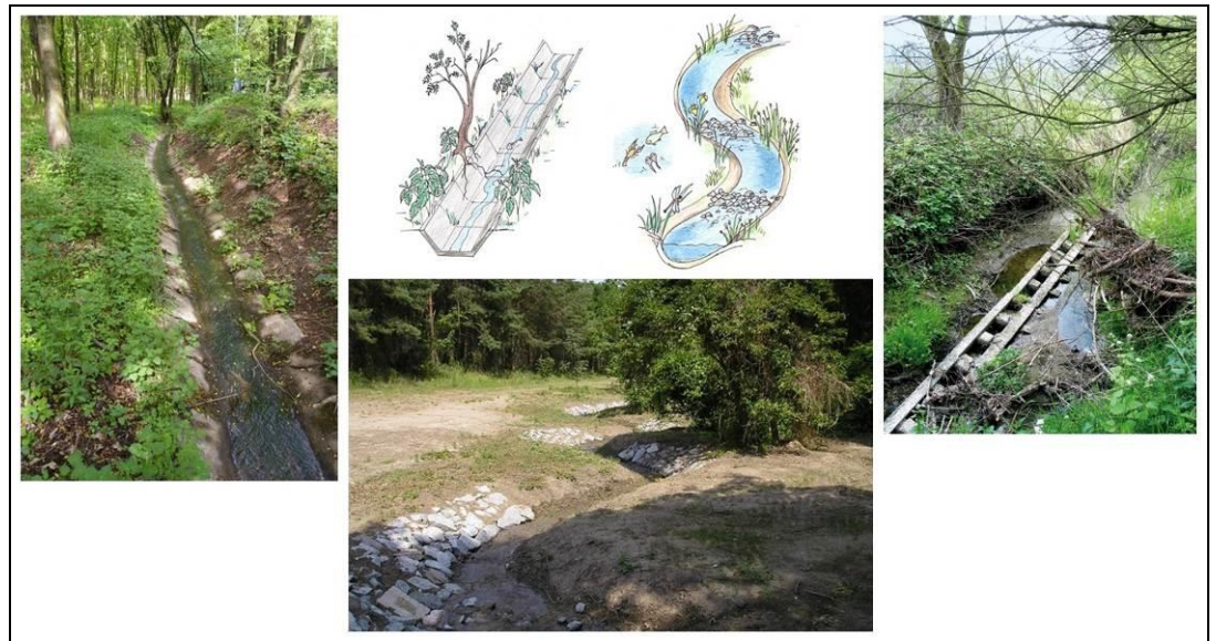
Obrázek 88 Příklad nevhodně upraveného vodního toku (vlevo), technicky revitalizovaného (uprostřed) a samovolně renaturovaného (vpravo) vodního toku. Přirozená renaturace si však s některými předešlými zásahy člověka (polovegetační tvárnice) poradit nedokáže a k obnově přirozeného vzhledu koryta je nutný technický zásah (zdroj: Lesy hlavního města Prahy; Just 2009).
